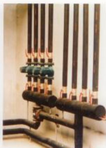
Μόνωση σωλήνων με ARMAFLEX
