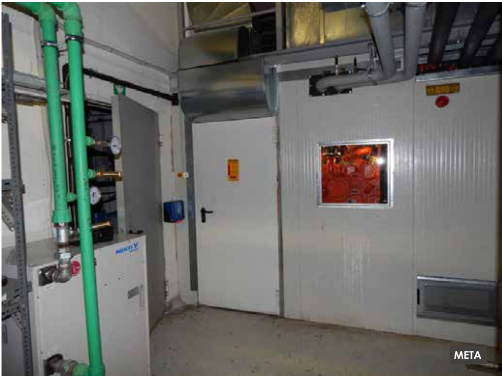
Ηχομονωτικό δωμάτιο μονάδας συμπαραγωγής σε ξενοδοχείο
