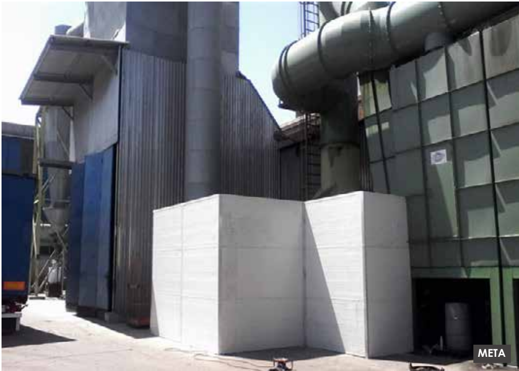
Ηχομόνωση φυγοκεντρικού ανεμιστήρα σε βιομηχανία
