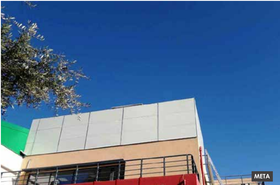
Ηχοπέτασμα σε κλιματιστικές μονάδες κολυμβητηρίου
