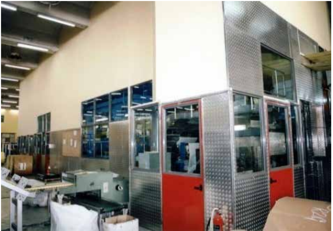
Ηχομόνωση μεγάλης εκτυπωτικής μονάδας
