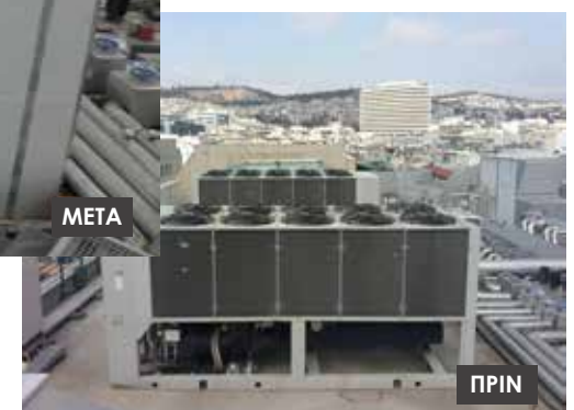
Ηχομόνωση ψυκτών κλιματισμού Υπουργείου
