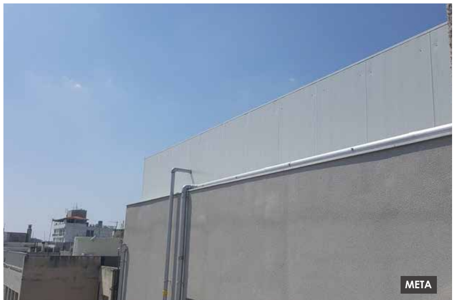
Ηχομονωτικό πέτασμα σε μηχανολογικό δώμα κτιρίου
