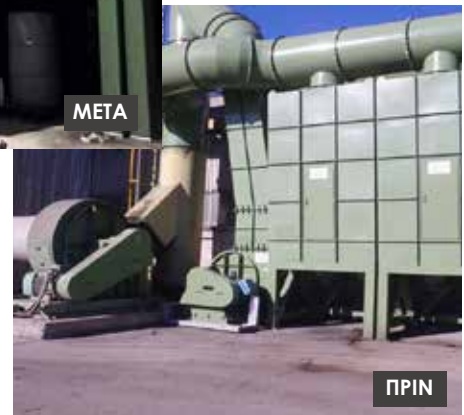
Ηχομόνωση φυγοκεντρικού ανεμιστήρα σε βιομηχανία
