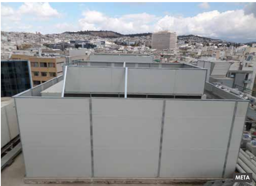
Ηχομόνωση ψυκτών κλιματισμού Υπουργείου
