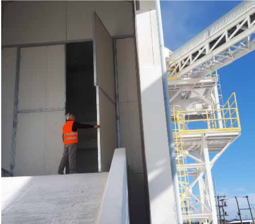
Πολύφυλλη ηχομονωτική θύρα σπαστήρα ορυκτών
