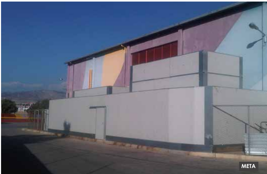
Ηχομόνωση ψυκτικού συγκροτήματος σε βιομηχανία τροφίμων
