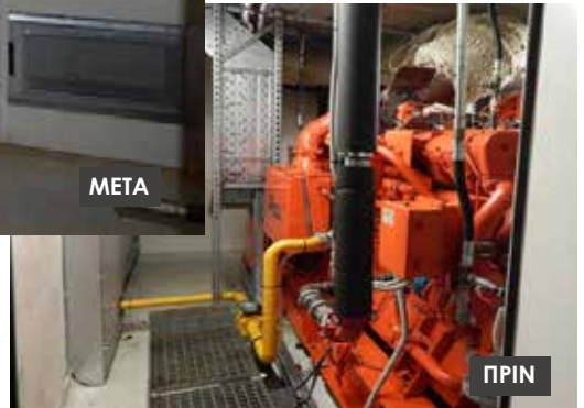
Ηχομονωτικό δωμάτιο μονάδας συμπαραγωγής σε ξενοδοχείο
