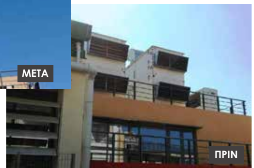
Ηχοπέτασμα σε κλιματιστικές μονάδες κολυμβητηρίου
